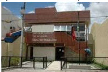
Figura 6: Vista frontal da edificação.
