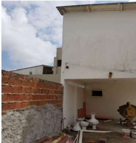
Figura 2: Edificação colada ao terreno vizinho
