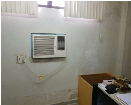
Figura 4: Edificação colada ao terreno vizinho
