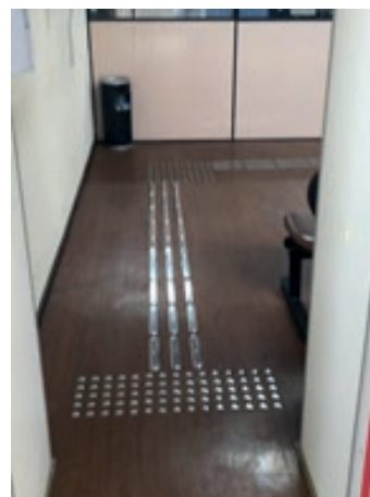
Piso tátil em inox direcional e de alerta na Vara do Trabalho de Guarabira
