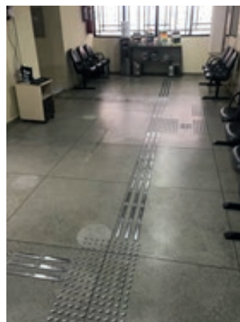
Piso tátil em inox direcional e de alerta na Vara do Trabalho de Sousa
