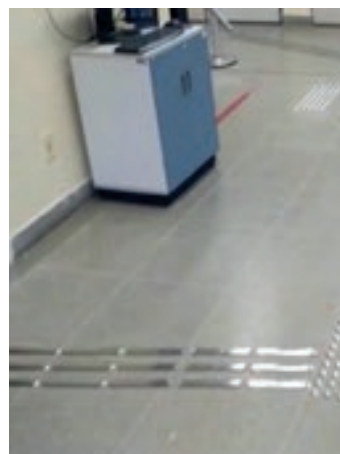
Piso tátil em inox direcional e de alerta na Vara do Trabalho de Patos
