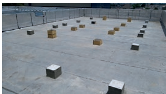
Bases em concreto para instalação das estruturas metálicas para instalação dos painéis fotovoltaicos no bloco A
