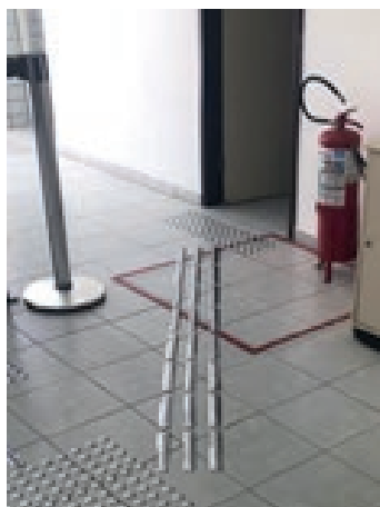
Piso tátil em inox direcional e de alerta na Vara do Trabalho de Catolé do Rocha
