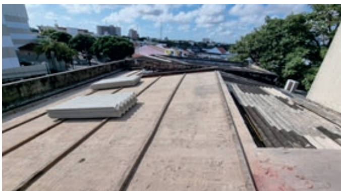
Retiradas de telhas antigas
