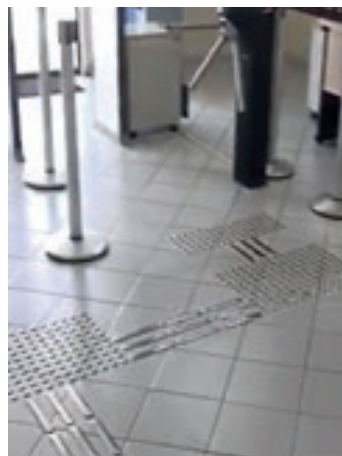
Piso tátil em inox direcional e de alerta na Vara do Trabalho de Itaporanga
