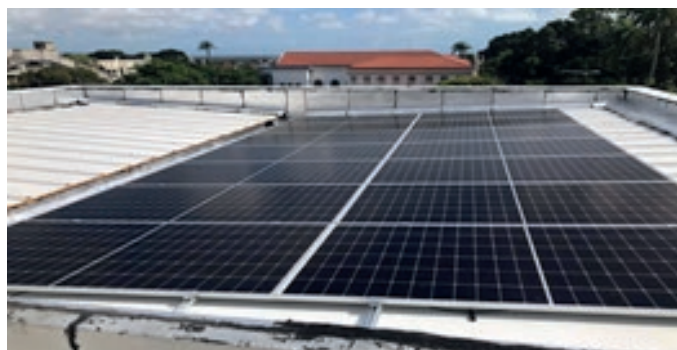
Painéis instalados no bloco A
