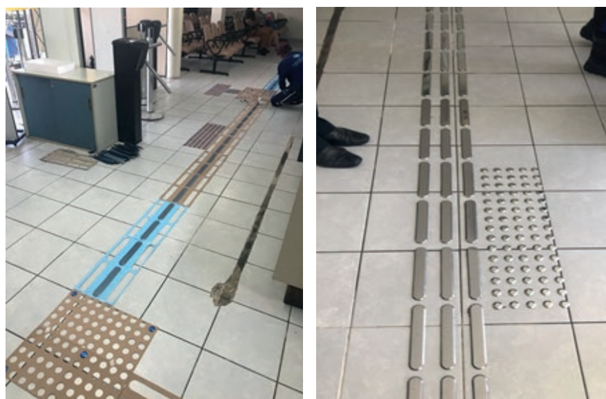
Piso tátil em inox direcional e de alerta instalado nos corredores no Fórum José Carlos Arcoverde Nóbrega em Santa Rita
